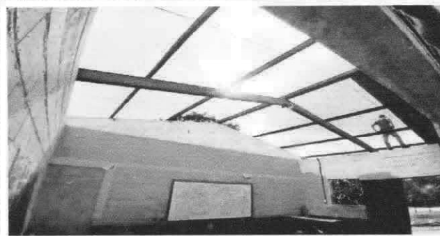
Foto 2: Mantenimiento de estructura de soporte de metal.
