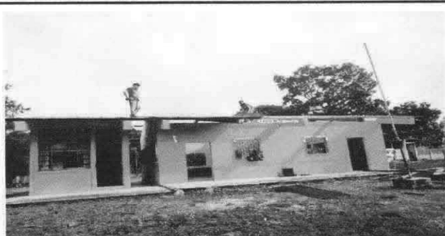
Foto 7: Instalación de lámina troquelada Aluzinc calibre 26.
