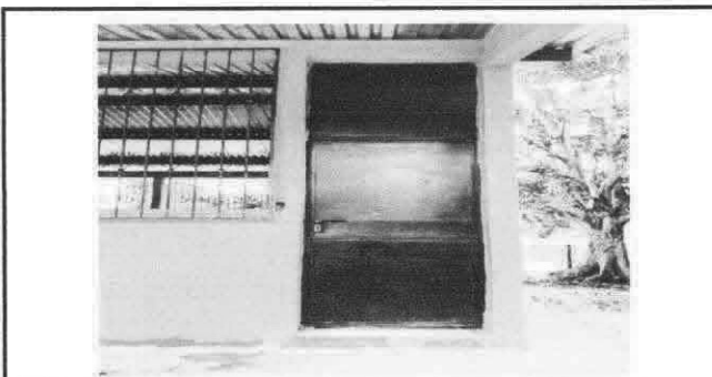
Foto 5: Mantenimiento a puertas de metal.
