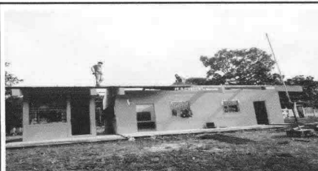
Foto 4: Sustrucción de capotes de lámina para lámina troquelada Aluzinc calibre 26.
