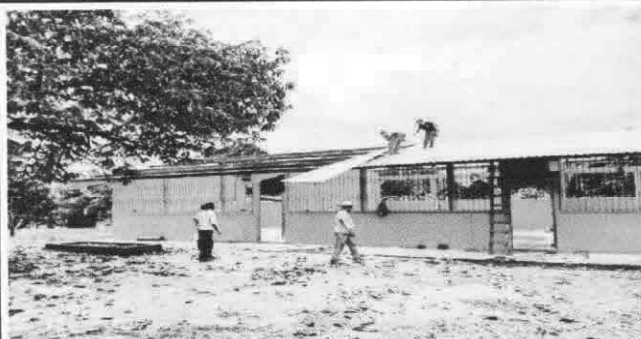
Foto 1: Sustrucción de lámina, por lámina troquelada Aluzin calibre 26.
