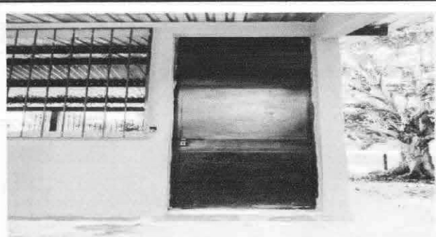
Foto 8: Sustitución de puertas.
